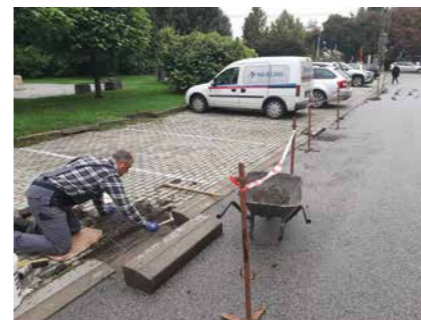
Opravili sme poškodenú dlažbu a obrubníky na parkovisku pred pošťou
