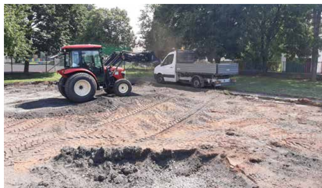
Vykonalí sme búracie, zemné a prípravné práce na osadenie nového multifunkčného ihriska v areáli základnej školy
