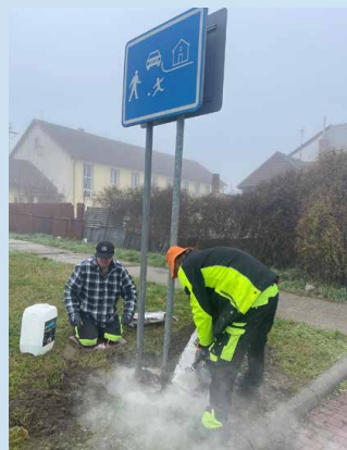
Osadenie novej dopravnej značky
