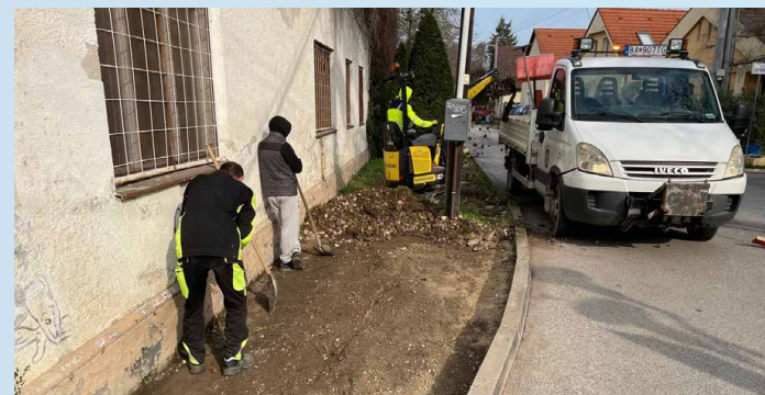
Predpríprava na odstavnú plochu na Irkutskej ulici
