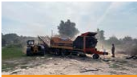
Drvenie dreveného odpadu – naštiepkovali sme 180 t.
