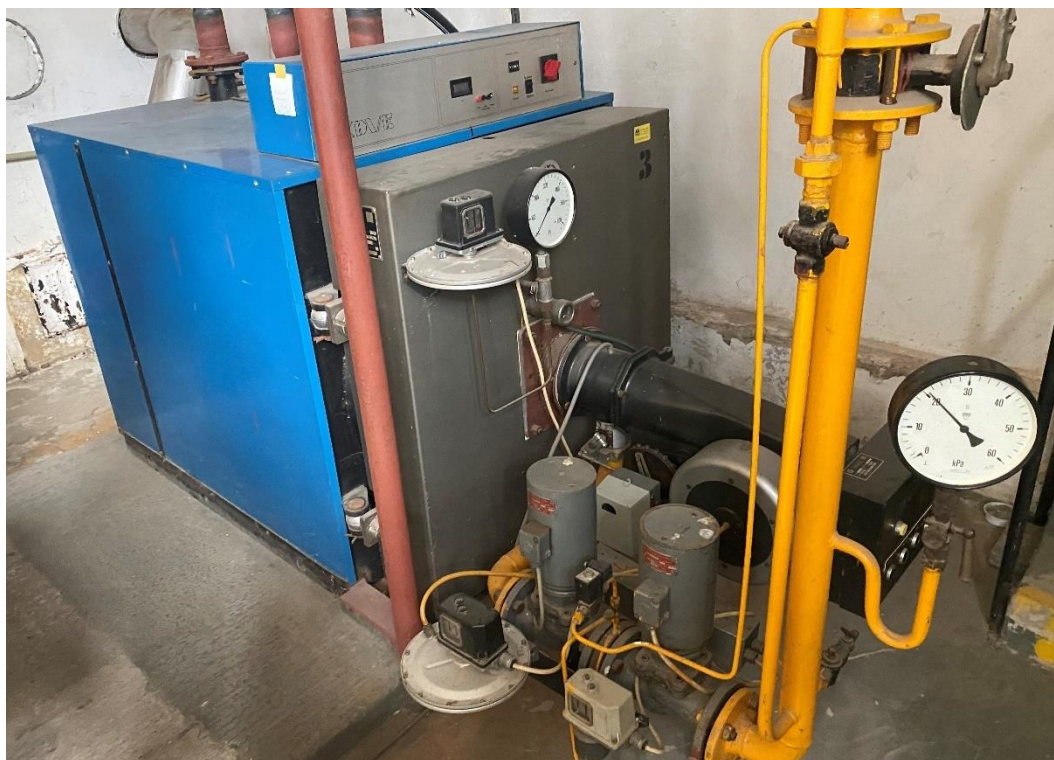
Obrázok 2: Pohľad na teplovodný kotol na zemný plyn – ZŠ Rusovce
