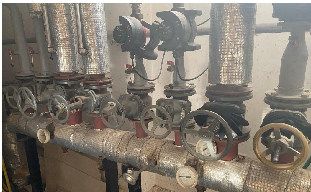
Obrázok 3: Rozdeľovač a zberač vykurovacej vody – ZŠ Rusovce
